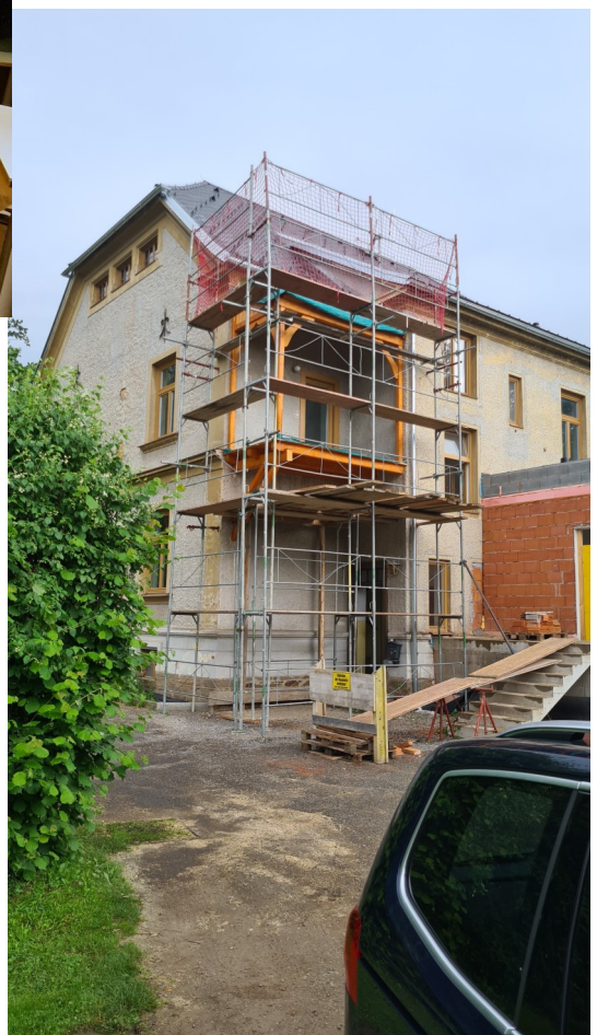
Rechts: Sanierung Pfarrhaus Stainz Balkon
